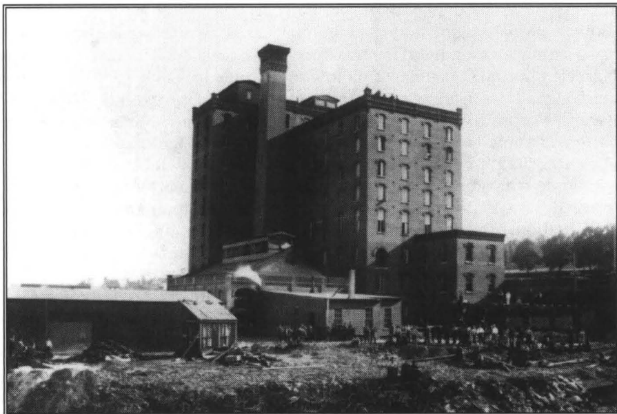
La Nova Scotia Sugar Refinery en construction au début des années 1880; ce sont les débuts de l'industrie à Halifax.
